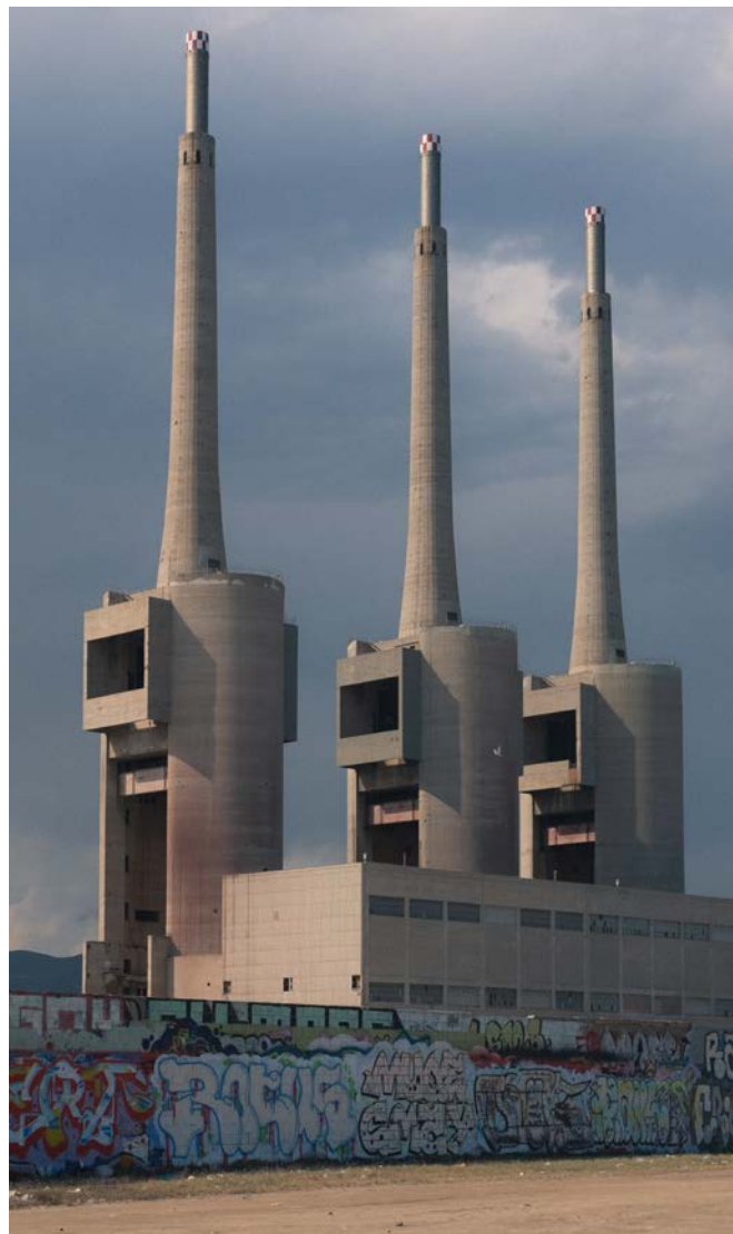
Fig 124 Central térmica de Sant Adrià
